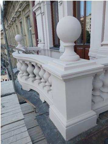
Рис. 9. Загальний вигляд балкону центральної частини фасаду після реставрації
