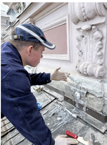
Рис. 5. Укріплення основи фасаду
