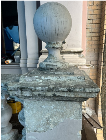
Рис. 3. Фрагментарний вигляд декоративного оздоблення центрального балкону після демонтажу аварійних зон
