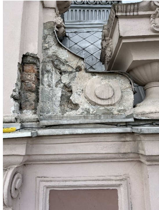
Рис. 2. Фрагментарний вигляд декоративного оздоблення фасаду після демонтажу аварійних зон
