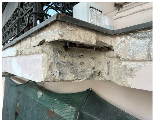
Рис. 6. Процес армування у місцях втрат основи фасаду
