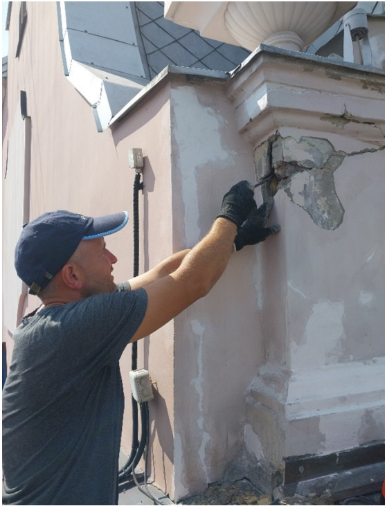
Рис. 1. Демонтаж аварійних зон на верхній частині фасаду
