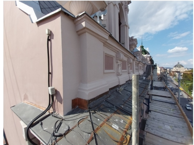
Рис. 10. Фрагментальний вигляд верхньої частини фасаду після реставрації
